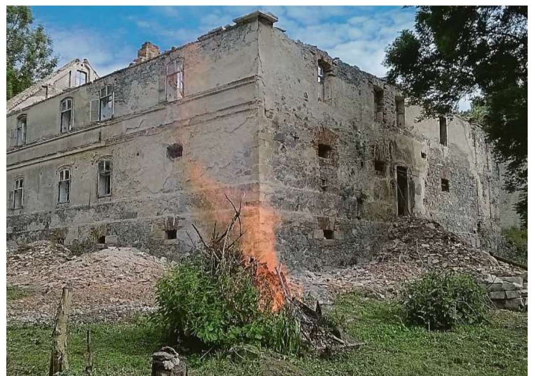
Manželé Jílkovi opravují mlýn z 18. století. Dole je pohled na část mlýna před opravou. Místo je už ale zbavené náletů, které tu za desítky let chátrání stavby rostly. Nahoře je mlýn v současném stavu. Foto: Z. Mendlová a archiv
